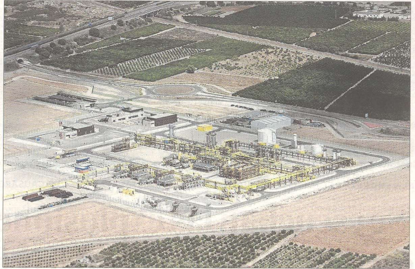
Instal·lacions de la planta terrestre del projecte Castor, al terme de Vinaròs. FOTO: JOAN EVILLAS
