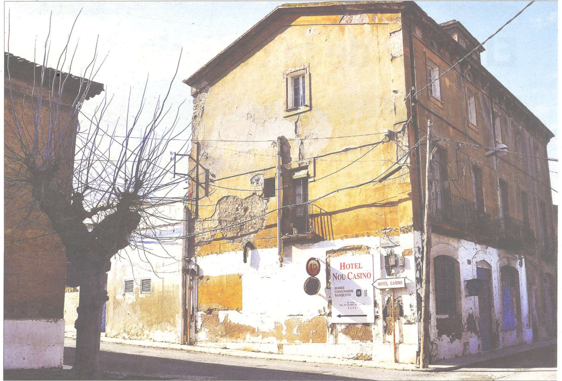
La colònia industrial, construïda a principi del segle xx, es troba en un estat de degradació important per falta de manteniment. NÚRIA CARO
