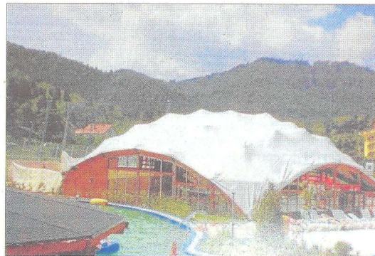
Exemple de la tipologia de cobertura de fusta i lona que s'utilitzarà a Móra d'Ebre. FOTO: AJUNT. MÓRA D'EBRE
