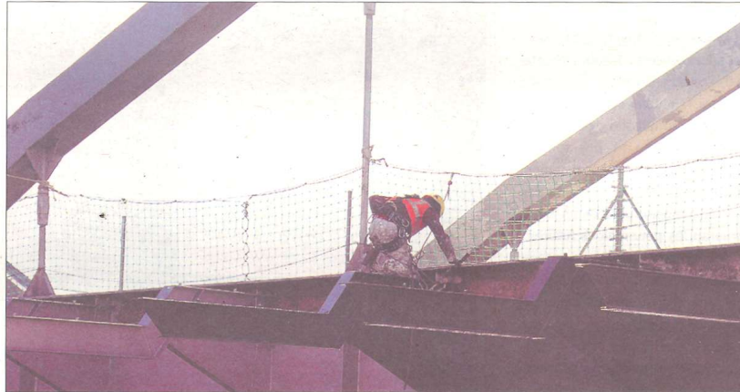
Les obres del pont de l'Estat de Tortosa es van reprendre aquesta setmana. / NÚRIA CARO
