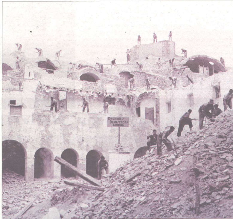
Fotografia que reflecteix l'activitat de Regiones Devastadas. Es tracta de l'enderroc (1941) de l'antic convent dels carmelitans descalços (carrer de Santa Anna, Tortosa), previ a la construcció de les actuals escoles de Remolins. FONTS J. DAUFÍ
