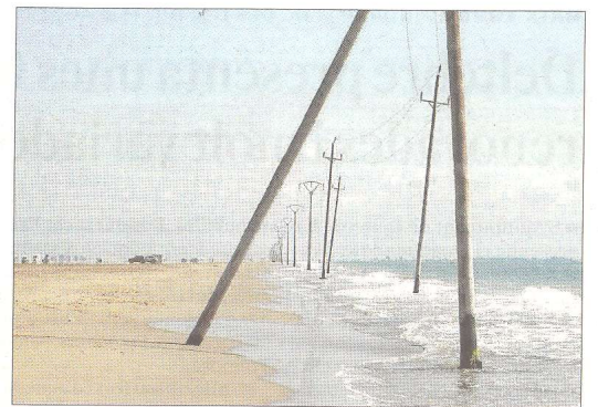
Aquest és l'estat actual de l'antiga línia aèria, amb pals dins del mar, que ara es desmantellarà. FOTO: JOAN REVILLAS
