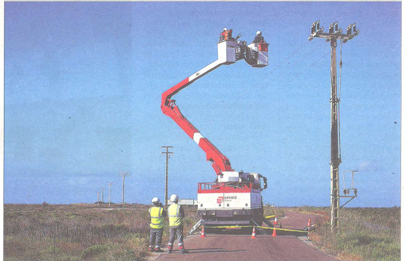
Un equip especial d'Endesa va tallar el cablejat de l'antiga línia elèctrica del Trabucador. / CEDIDA
