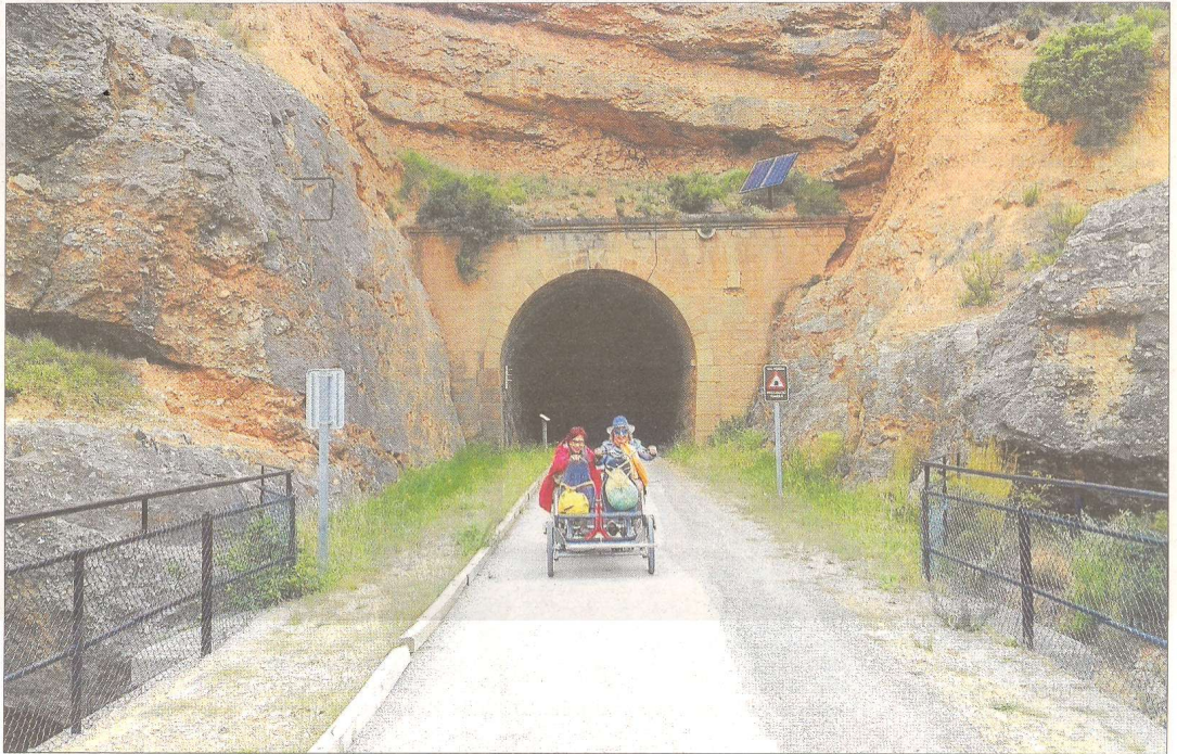
Circulant en un vehicle de pedals al tram de la Terra Alta de la Via Verda. FOTO: J.R.C.
