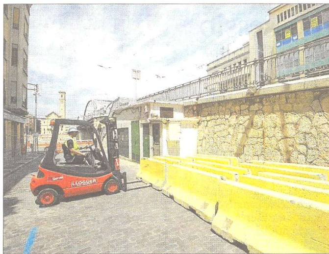
Acumulació de material d'obra al carrer Pintor Gimeno, a tocar del pont de l'Estat. FOTO: JOAN REVILLAS
