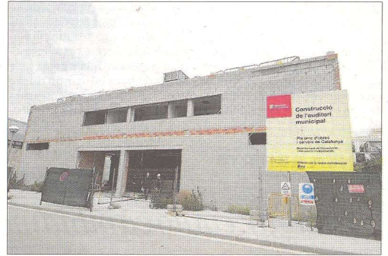
Aquest és l'estat actual de l'edifici que ha d'acollir l'auditori municipal de Sant Carles de la Ràpita. FOTO: JOAN REVILLAS
