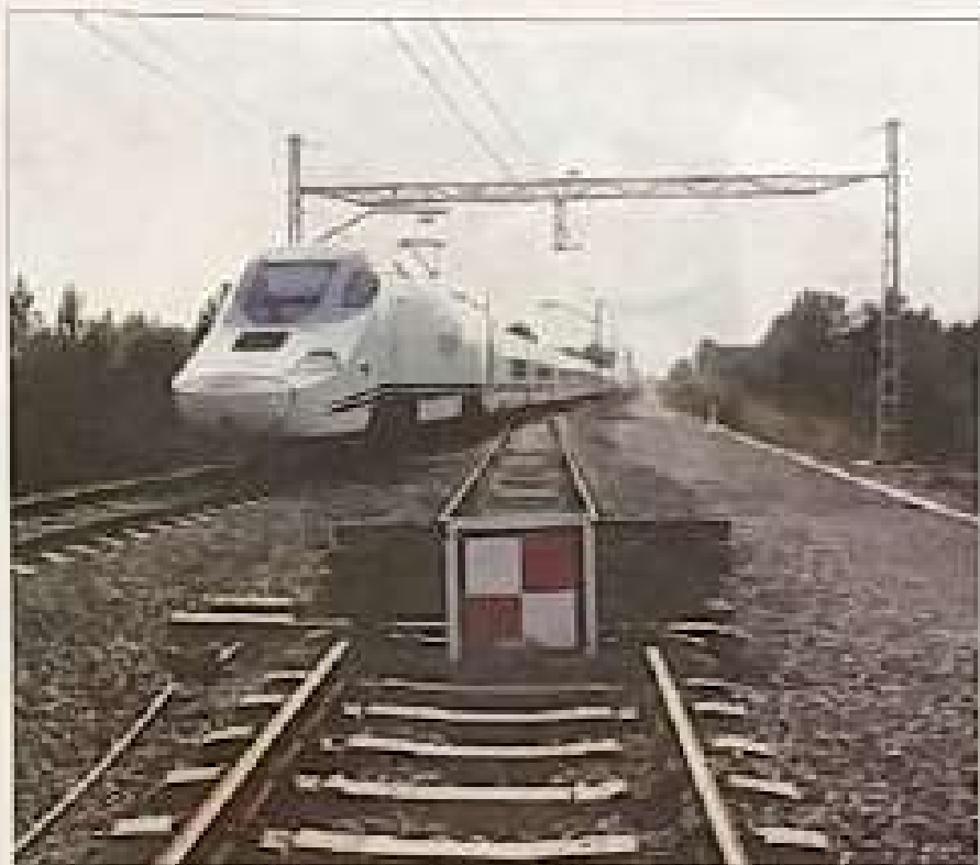
El punt d'enllaç entre la nova variant Vandellòs-Tarragona i el traçat actual a Vandellòs. / CEROA
