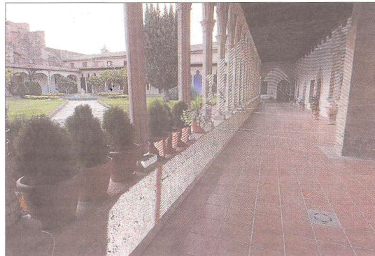
Ala nord del claustre del convent de Santa Clara, ahir a la tarda, amb una primera exhibició de la instal·lació lumínica. FOTO: JOAN REVILLAS
