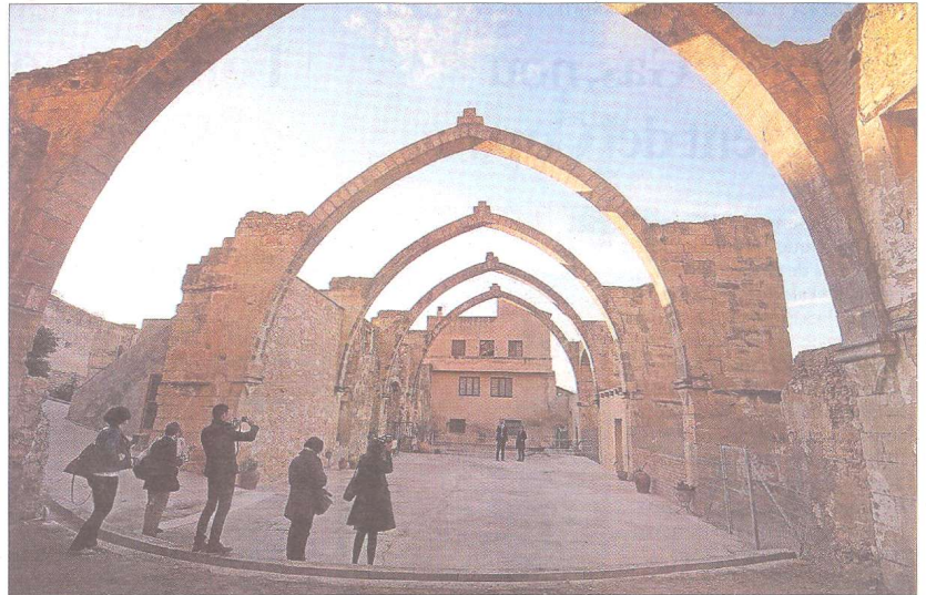
Les cinc magnífiques arcades gòtiques de l'antiga església del convent, restaurades, ahir. FOTO: JOAN REVILLAS
