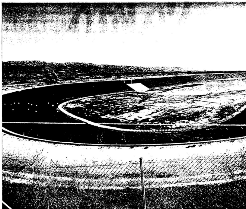
Una de les grans basses de regulació del primer sector del regadiu. FOTO: JOAN REVILLAS
