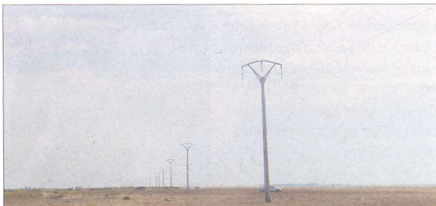
La línia elèctrica travessa la barra del Trabucador. / L.B.
