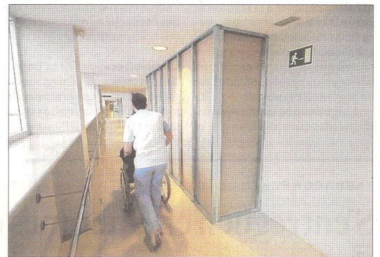
A la dreta de la imatge, una de les zones on s'està treballant en l'adequació de la normativa antiincendis. FOTO: JOAN REVILLAS
