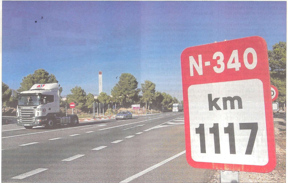
Punt quilomètric 1117 de la carretera N-340, intersecció a Sant Jordi d'Alfama, on s'ha construït una de les 11 rotondes programades. FOTO: JOAN REVILLAS
