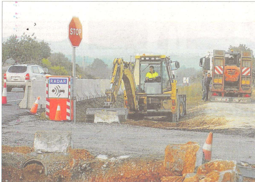
Avancen les obres de la rotonda de la N-340 al Perelló. Operaris i màquines treballen des d'aquesta setmana en la construcció de la primera rotonda, de les onze previstes al territori per tal d'alentir el trànsit a la N-340 i evitar accidents. FOTO: JOAN REVILLAS
