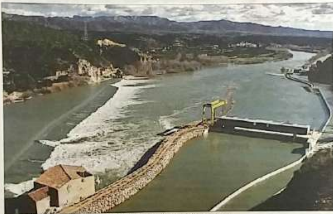
L'assut de Xerta i la central hidroelèctrica, semblant a la que Sercosa projecta ■ ARXIU
