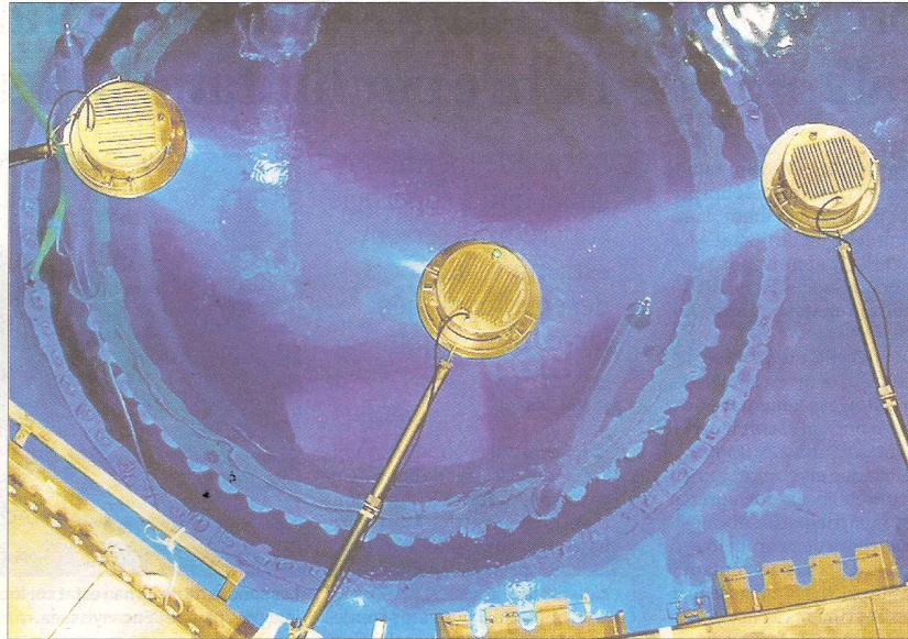
La cavitat del reactor, inundada, durant les maniobres de moviment de combustible. FOTO: ANAV
