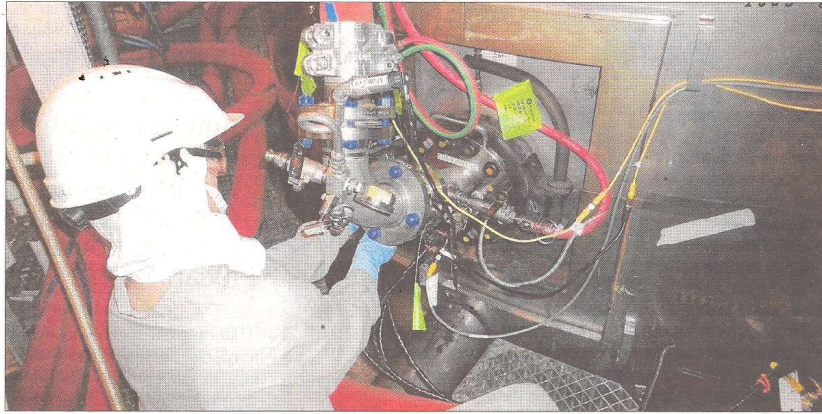
Treballs a la planta nuclear, durant el període de recàrrega. FOTO:ANAV
