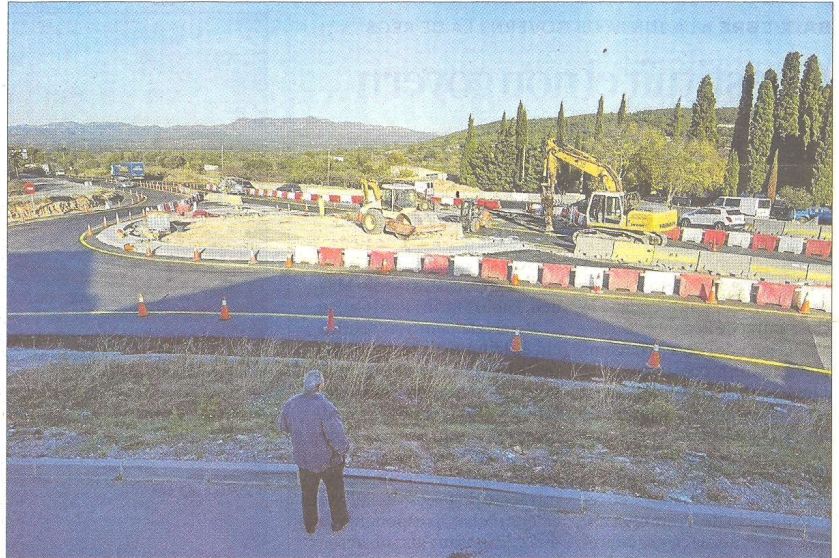
Estat de les obres de la rotonda de la N-340 al Perelló. FOTO: JOAN REVILLAS
