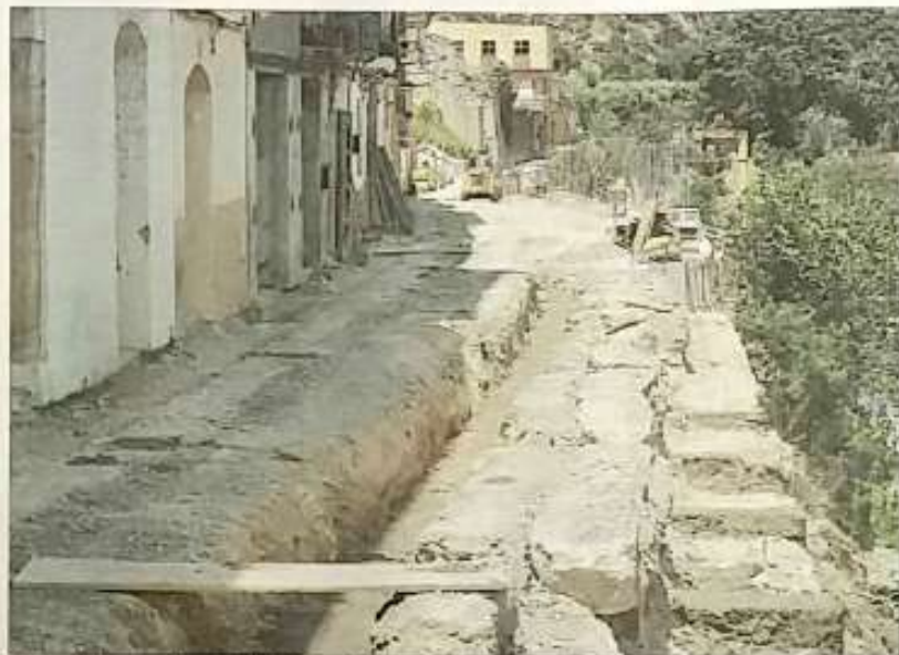
Imatge de les obres de remodelació integral del passeig de l'Ebre de Mora d'Ebre, l'any passat. FOTO JOAN REVELLE
