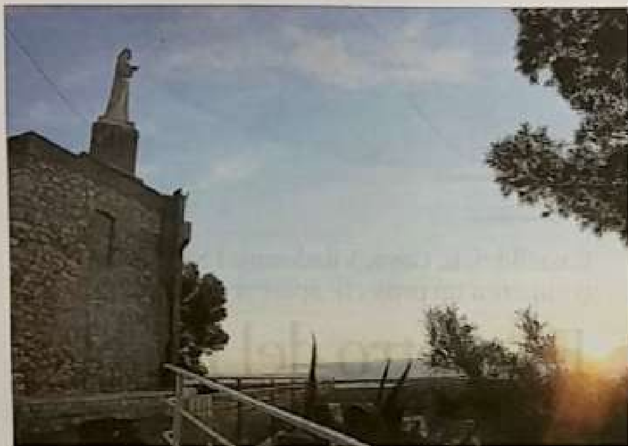
Imatge actual del Crist i la creu, inaugurada el 1965 a la Ràpita en homenatge "als caiguts per Espanya"
