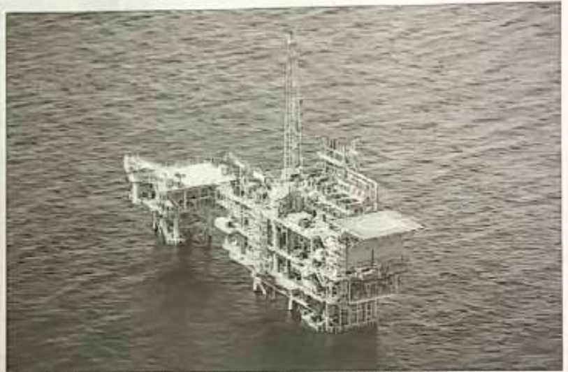
Imatge de la planta marítima del projecte Castor, davant de les costes del delta de l'Ebre. FOTOC: JAMES REVILLAS
