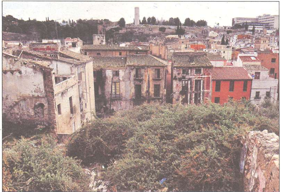
Una imatge de la part més deteriorada del barri Castell. / NÚRIA CARO
