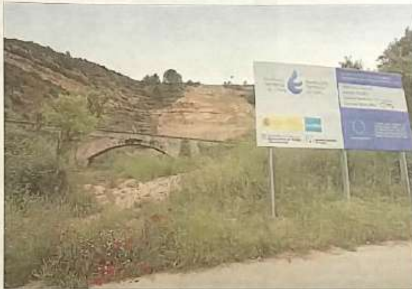
Cartell d'Acuamed per l'obra d'un dipòsit a Ascó. FOTO JOAN REYLLAS
