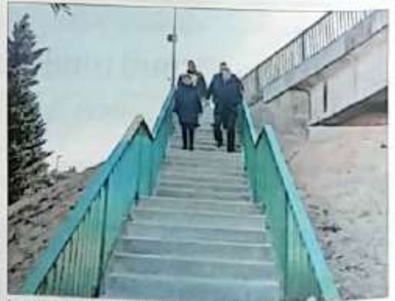
Imatge d'una de les dos escales integrada al talús del pont.
