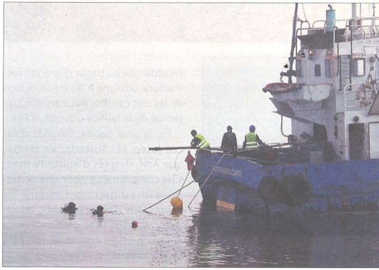
Bussos, treballant en l'estesa de cable aquest dilluns passat. / ACN
