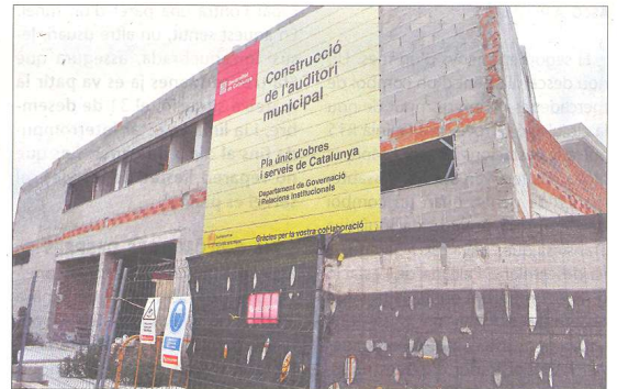
Imatge de la façana exterior de l'edifici inacabat. / NÚRIA CARO
