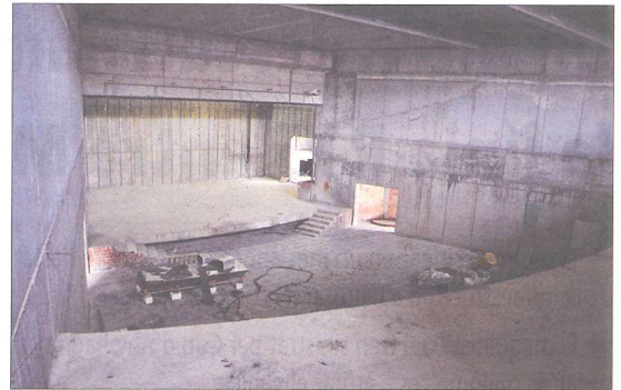
Estat actual de l'interior de l'auditori. / N. CARO
