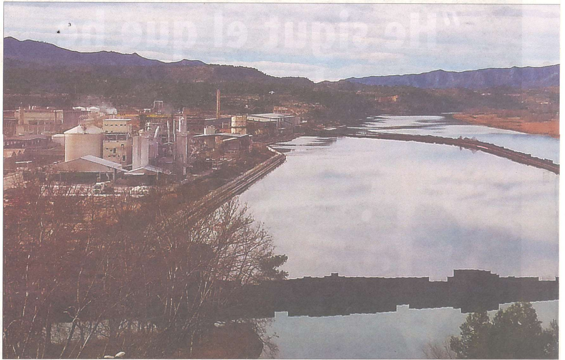
L'extracció dels llots contaminats del pantà de Flix va finalitzar a finals d'any, però al doble tancat de palplanxat hi ha dos hectòmetres cúbics d'aigua contaminada que s'han de tractar.
