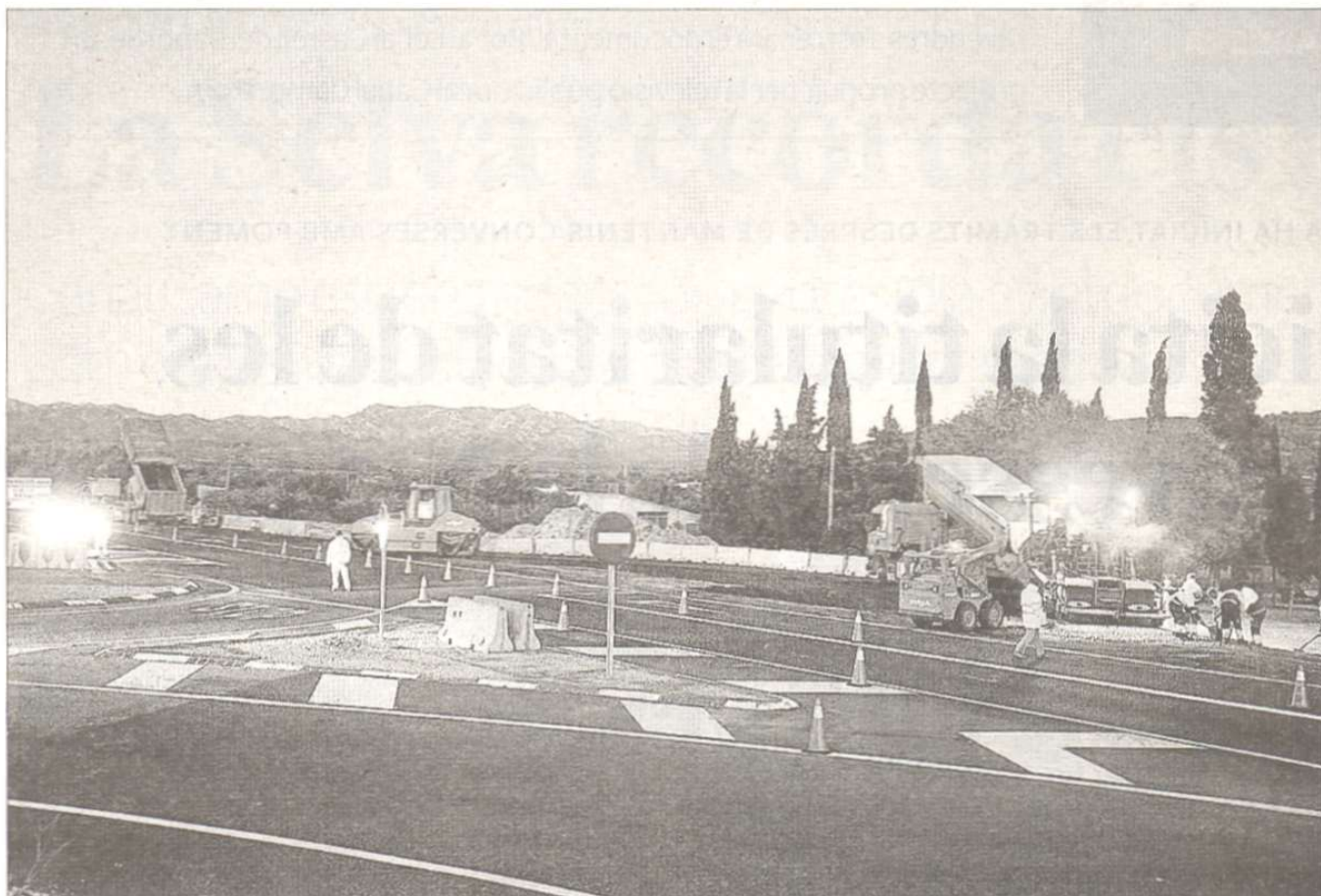
Treballs a la carretera N-340, ahir a la tarda, al Perelló. FOTO: JOAN REVILLÁS
