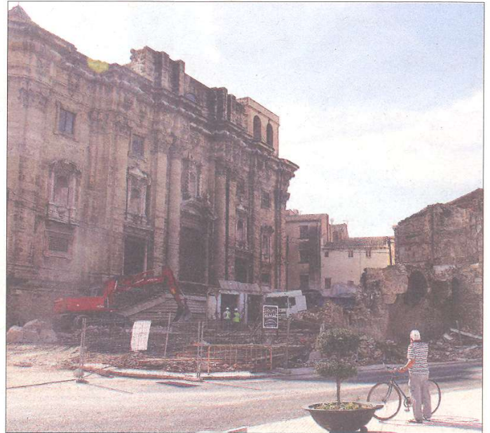
Estat de les obres d'enderrocament aquest dimarts passat. / ACN
