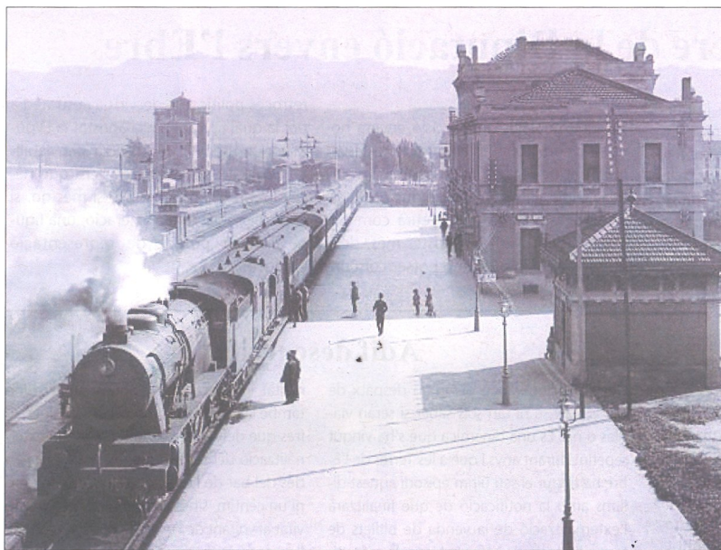
L'estació de Móra la Nova és històrica a la Ribera d'Ebre i va arribar a tindre un miler de treballadors.
