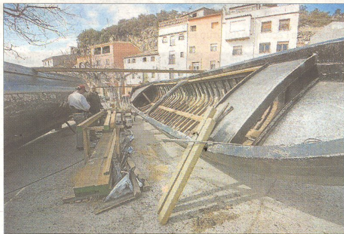
Operaris el mes d'abril treballant en la reparació dels llaguts del pas de barca. FOTO: JOAN REVILLAS
