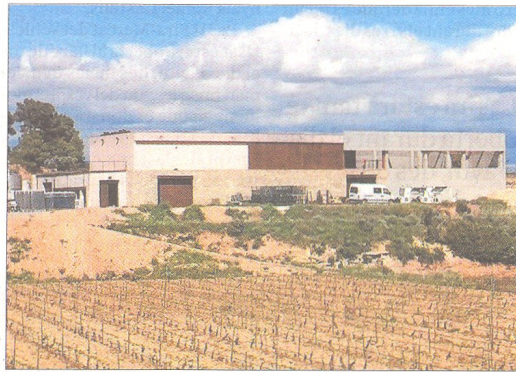
Imatge del nou edifici en construcció al costat del celler Edetària, al terme de Gandesa. FOTO: EDETÀRIA
