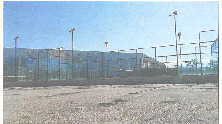
Estat actual de les instal·lacions, que ja porten nou mesos tancades.
