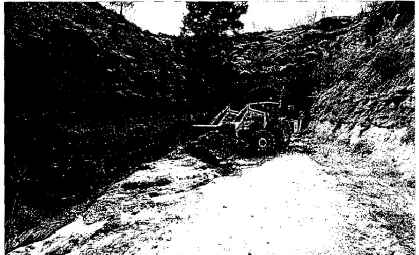
Una màquina retirava ahir al migdia gran quantitat de fang a l'entrada d'un túnel de la via. FOTO: JOAN REVILLAS
