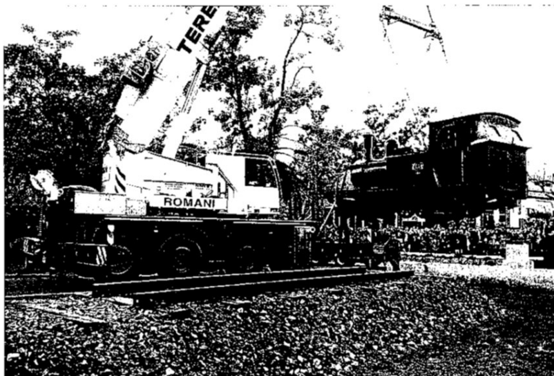
El moment en què es va col·locar la locomotora va ser de gran expectació. FOTO: JOAN REVILLAS
