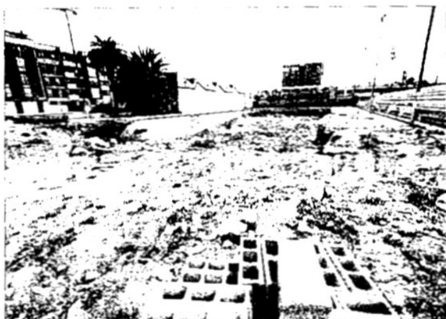
Imatge de les antigues piscines municipals a l'aire lliure de Tortosa, abandonades per la paralització de les obres. FOTO JOAN REVILLAS
