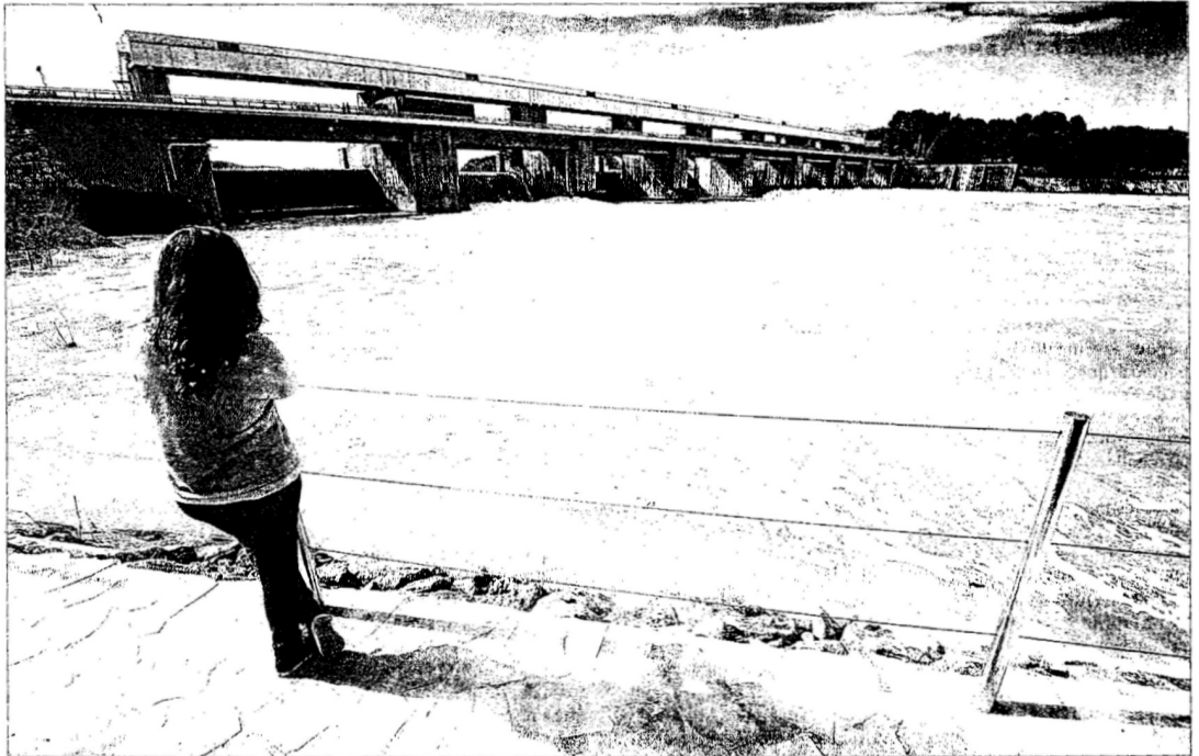
Aspecte de la presa de Flix, ahir al matí amb totes les comportes completament obertes. FOTO: JOAN REVILLAS
