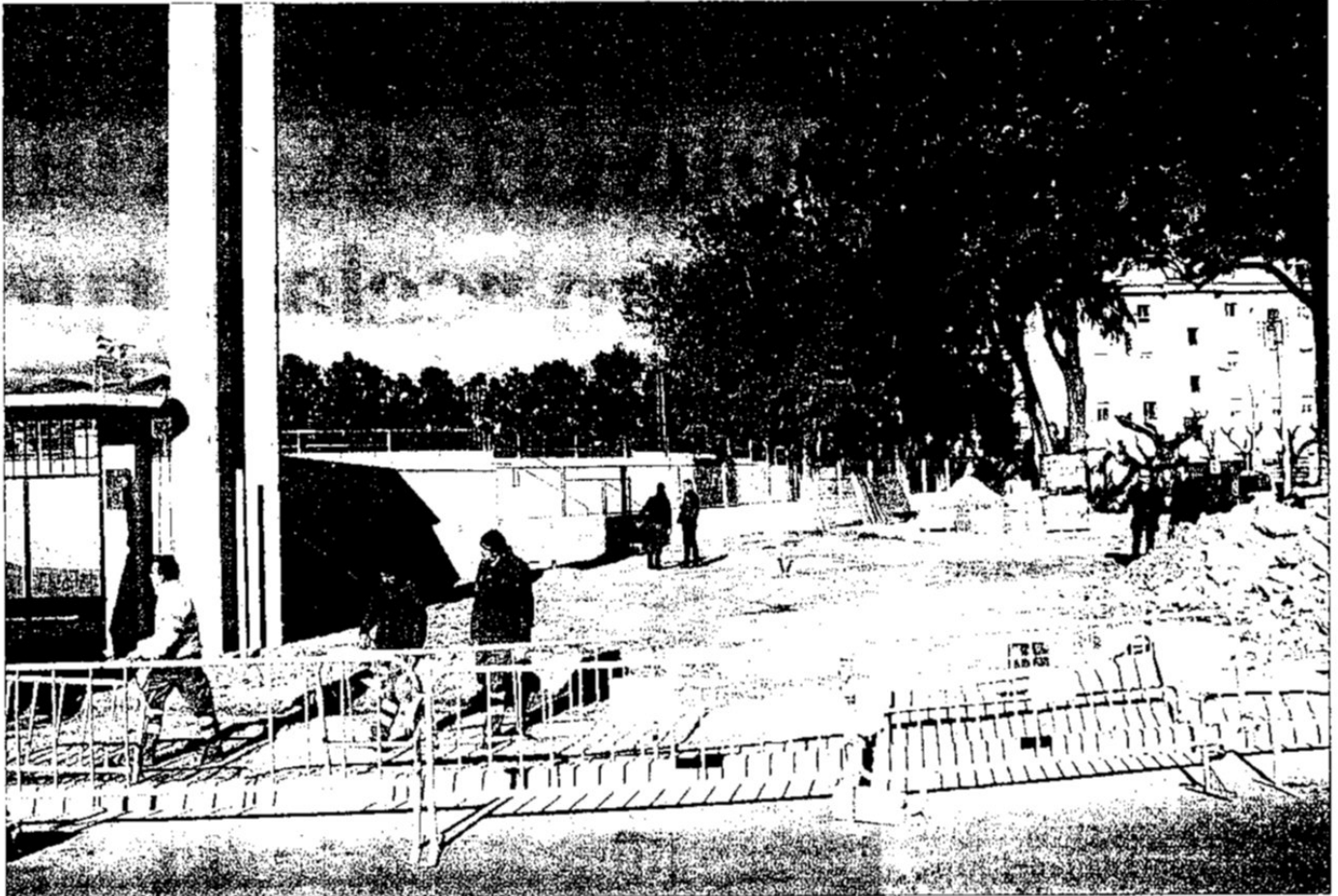
Estat de les obres d'aquest nou espai, ahir al matí. FOTO: JOAN REVILLAS
