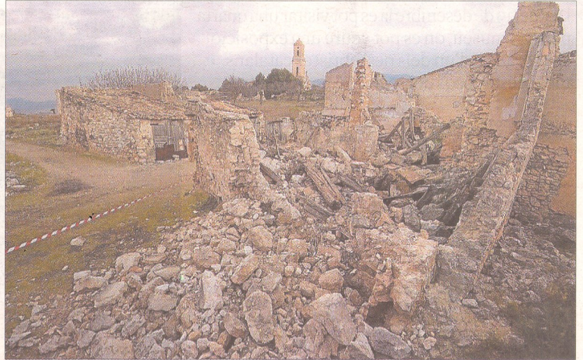
Paret lateral de la casa enrunada que s'ha esfondrat aquestes festes, ahir a la tarda. FOTO: JOAN REVILLAS
