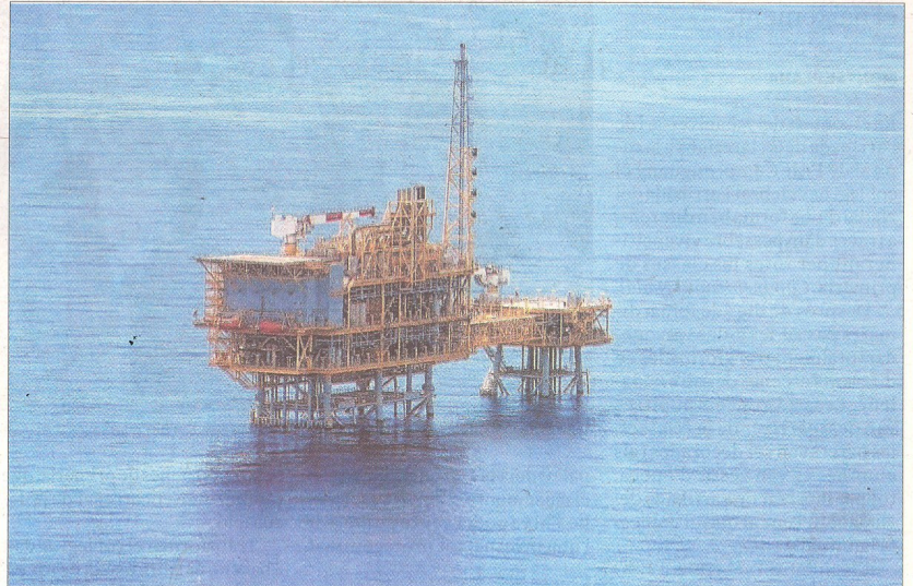
La plataforma marina del magatzem de gas Castor, davant la costa de Vinaròs i Alcanar. FOTO: JOAN REVILLAS
