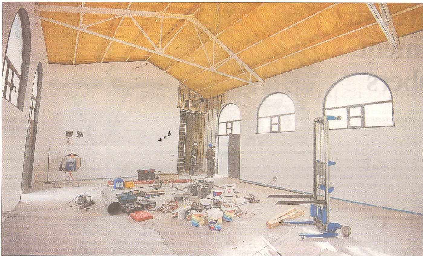
Estat actual de les obres a l'interior de l'antic escorxador d'Amposta. FOTO: JOAN REVILLAS
