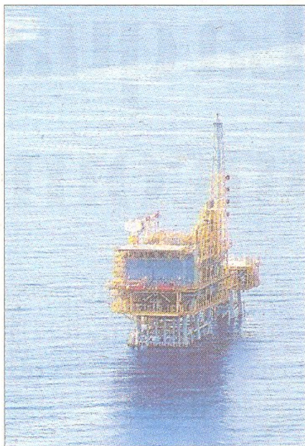
La plataforma marina del magatzem Castor. FOTO: DT
