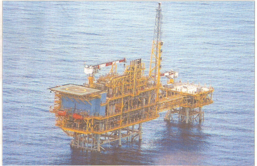
Imatge captada des de l'aire de la plataforma marina del magatzem de gas Castor. FOTO:DT
