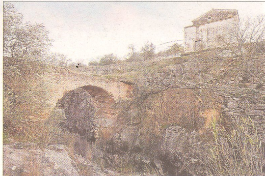
Panoràmica del pont del Molí de la Roca. FOTO: JOAN REVILLAS
