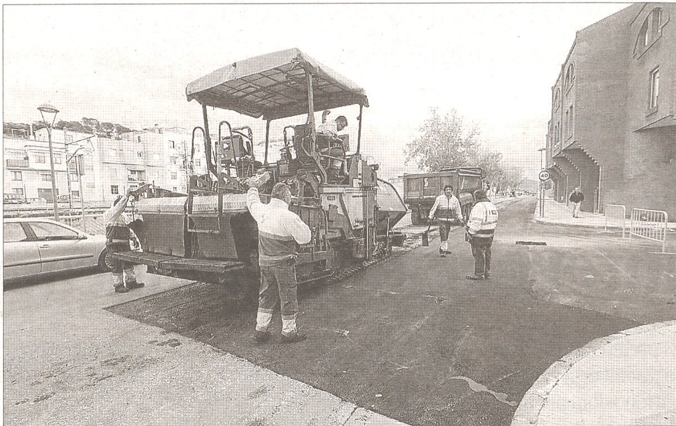
Treballs d'asfaltatge al carrer Ferran d'Aragó. FOTO: JOAN REVILLAS
