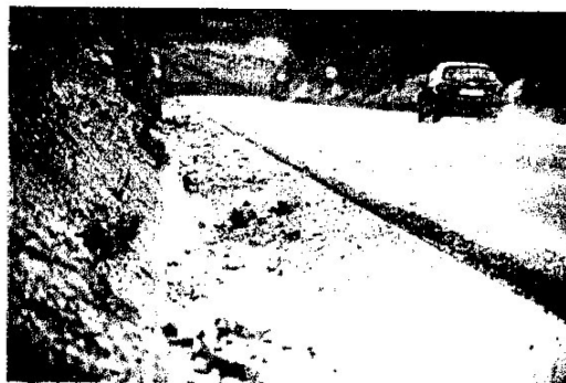
Petits despreniments de roques a la carretera T-741 a Flix, al nord de la Ribera d'Ebre. FOTO JOAN REVILLAS
