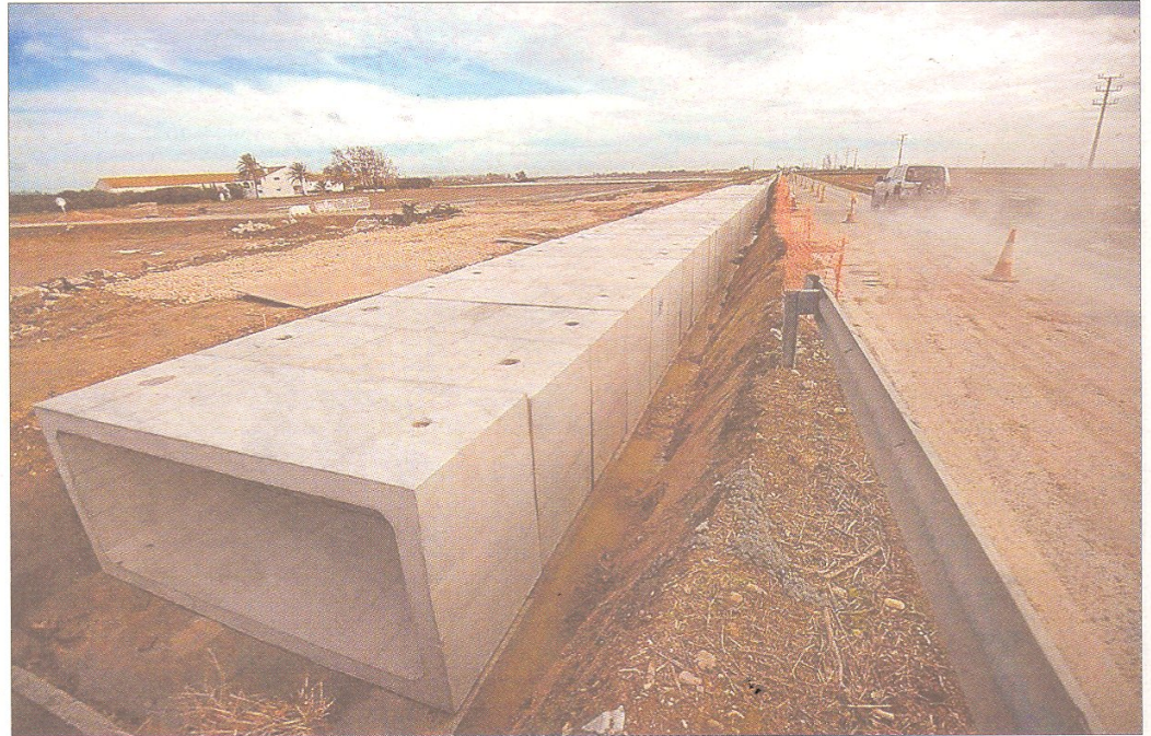
Estat actual de les obres a la carretera TV-3405. FOTO: JOAN REVILLAS
